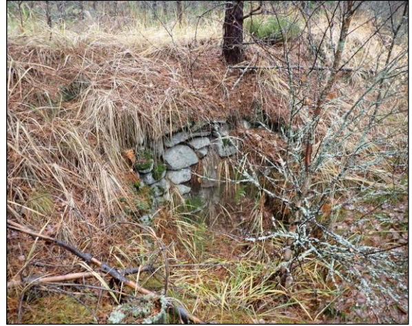
Kuva 4. Kylmämuurattu halssi, kuvattu koilliseen.
